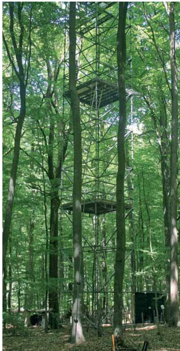
Meteorologischer Messturm auf der Level II-Core-Fläche Lüss
