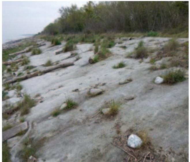
2) Flächige Abdeckung mit Geotextil
